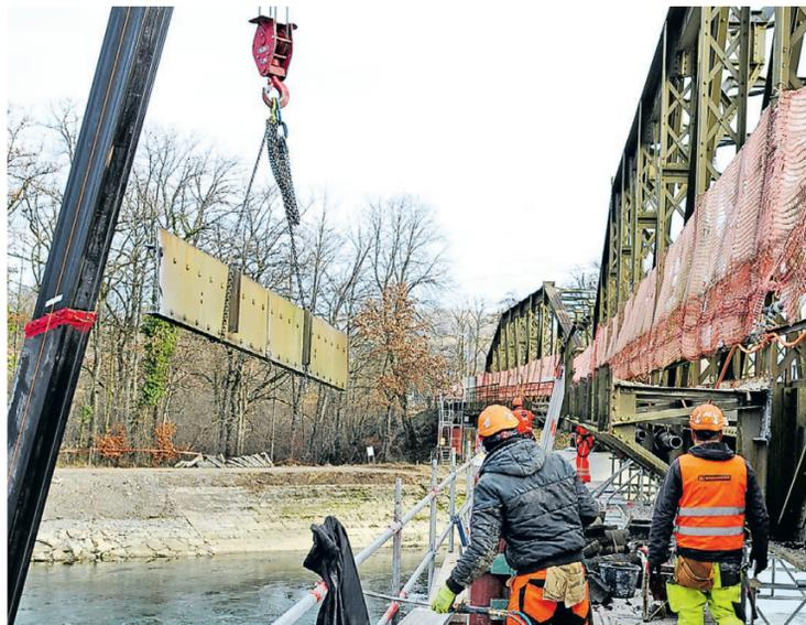
Mithilfe eines auf einem Ponton stehenden Krans werden die grösseren abgetrennten Elemente abgeführt.
