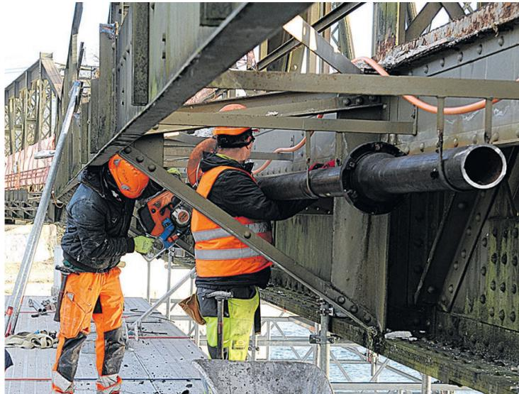
Stück um Stück werden die alten Rohre und Stahlprofile des Fussgängerstegs zurückgebaut.
