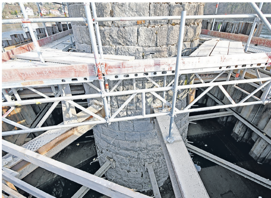
Blick auf einen Pfeiler: Das Mauerwerk am Pfeiler wurde vernagelt, damit sich keine Steine lösen. Die Eisenträger helfen, die in den Boden gerammten Stahlbohlen des Spundwandkastens in Position zu halten.
