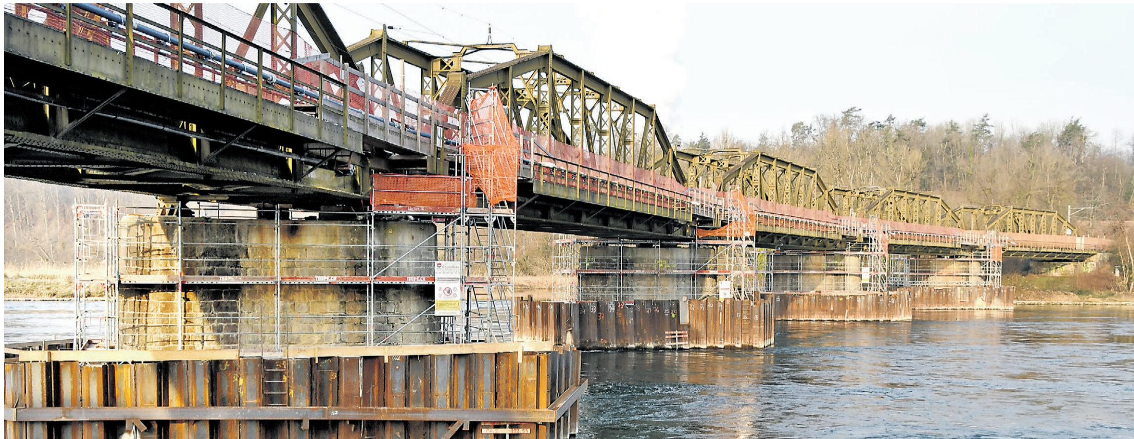
Die Sanierung der SBB-Brücke ist einen grossen Schritt weiter: Die Pfeiler sind eingerüstet und die Spundwandkästen errichtet. Sie waren notwendig, damit im Innern der Spundwandkästen, im Trockenen, die neuen Pfeilerfüsse betoniert werden konnten.
