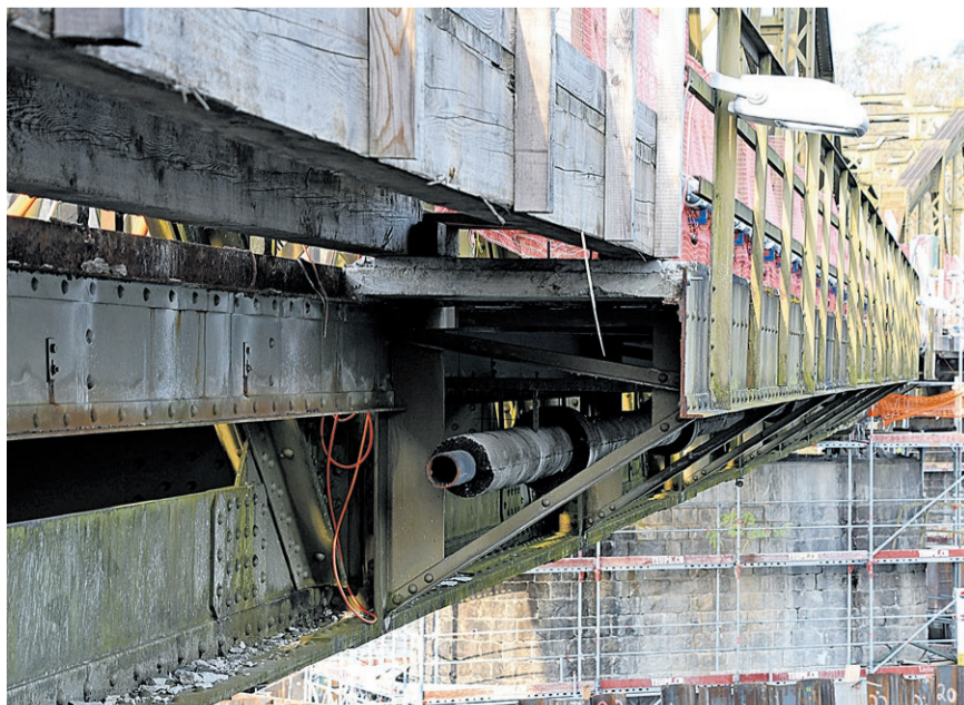
Blick an die Unterseite des alten Fussgängerstegs. Im Rahmen des Fussgängersteg-Ersatzes sollen die Betonplatten des Stegs durch Gitter ersetzt werden.
