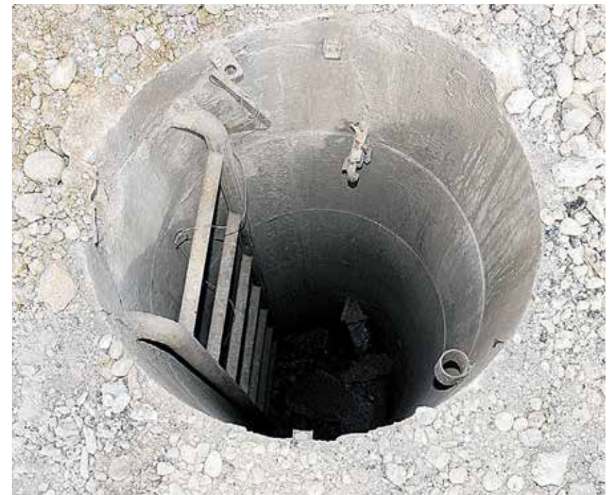
Eine der sechs gefundenen Sprengkammern.
