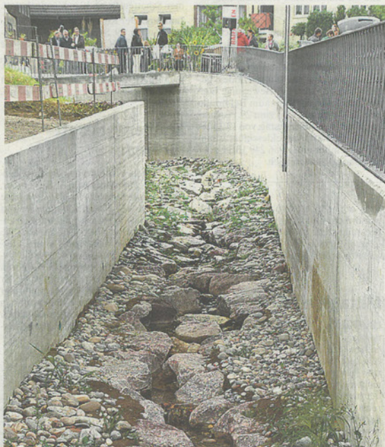
Ein naturnah gestaltetes Bachbett und sein Bächlein – dank der hohen Mauern ist Tegerfelden aber auch gerüstet für den Fall, dass der Gislibach einmal als reissender Bach herunterrauschen sollte.
