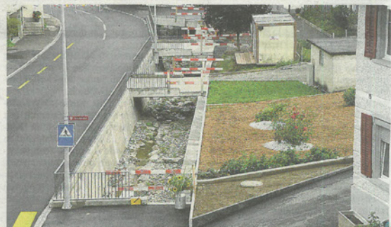
Blick auf den untersten Abschnitt des neugestalteten Gislibachs, kurz bevor er in die Surb fliesst: Die Flussübergänge zu den Liegenschaften am rechten Strassenrand wurden alle erneuert.
