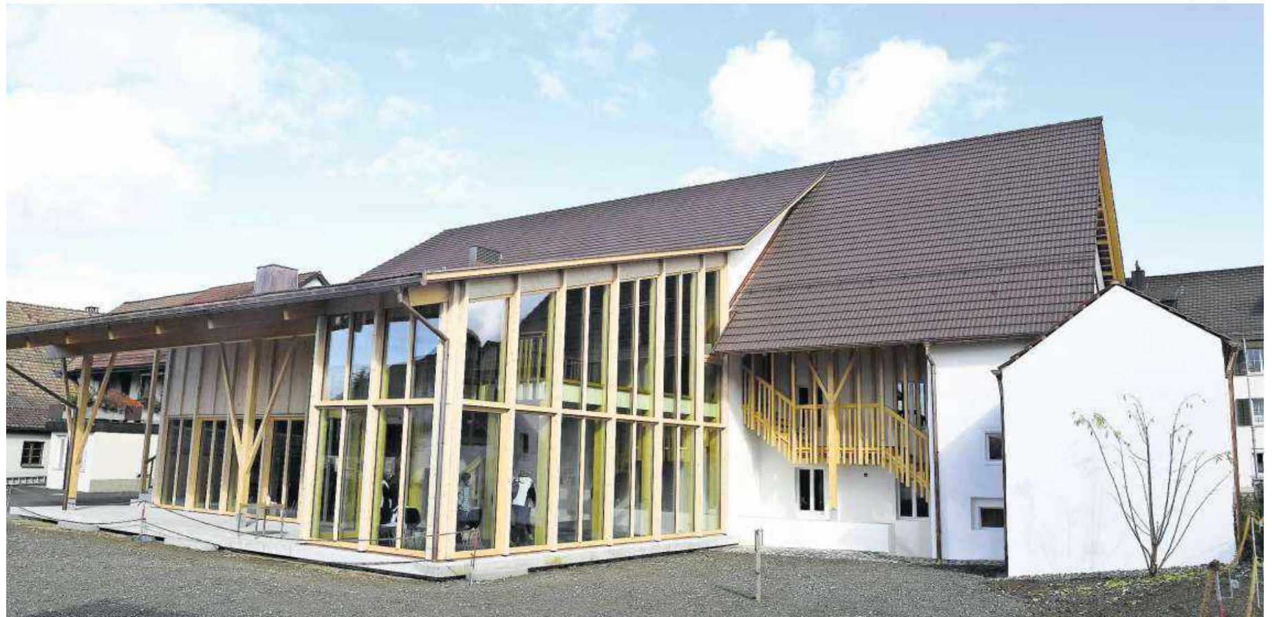
Die frisch renovierte und umgebaute Dorfschüür in Würenlingen entstand aus einem heruntergekommenen Bauernhaus aus dem Jahr 1783.
