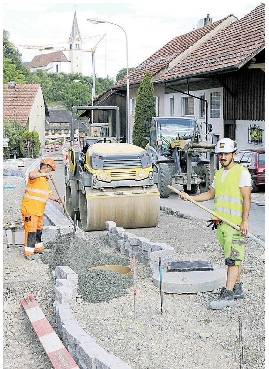
Einbau des Randsteins und eines neuen Schachts.
