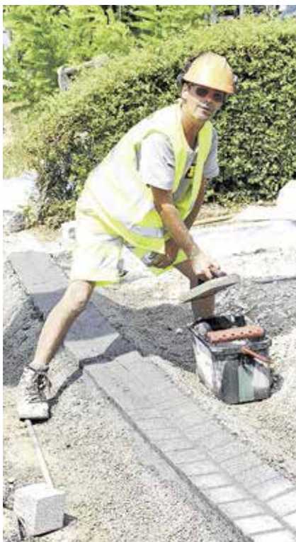
Der letzte Randstein ist gesetzt.
