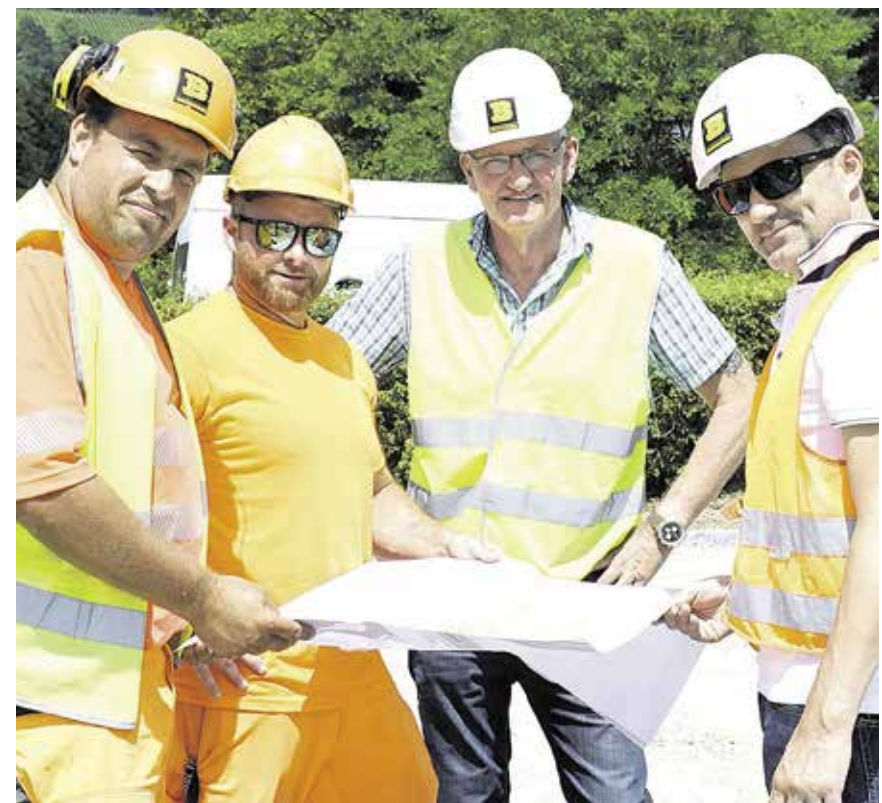
Baustellenbesprechung mit Dominic Jakob (Polier), André Bugmann (Leiter Bauamt), Heinz Ruef (Bauführer) und Urs Mrose (Bauleiter).
