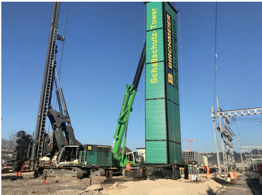
SBB Entflechtung Wylerfeld, Bern, 28'000 m<sup>2</sup> Spundwände mit eigener Schallschutzkonstruktion.
