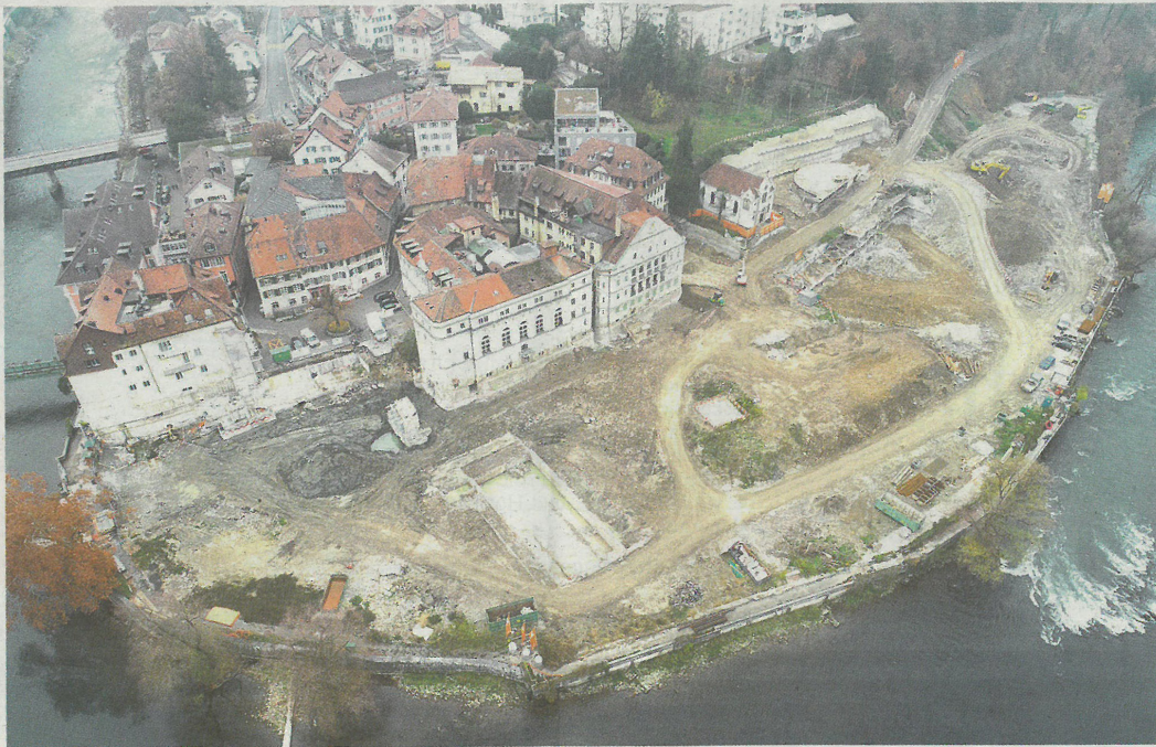
Blick aufs Bäderquartier im Dezember 2018 – ab Frühjahr 2019 soll hier das neue Thermalbad entstehen. Die Eröffnung ist für Herbst 2021 geplant.
